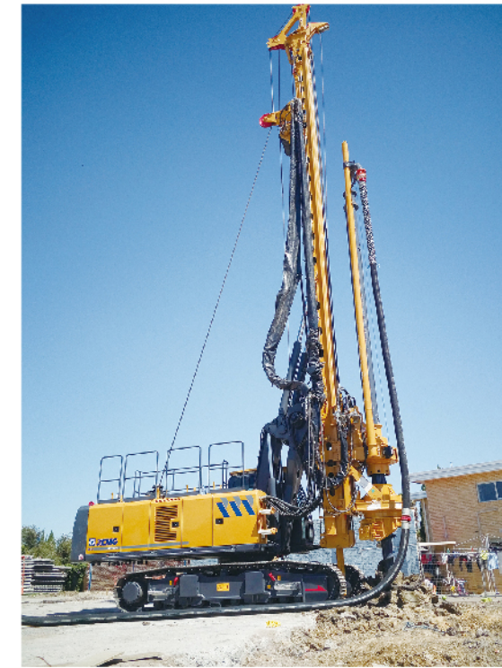
XR130E澳大利亚施工 XR130E works in Australia
